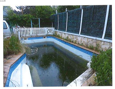
La piscine se compose d'un bassin coque avec ligne d'eau carrelée. Les margelles sont en dalles de pierres reconstituées, comme les plages de piscine. L'ensemble est ancien et en très mauvais état. Nous y trouvons deux skimmers et une buse de refoulement, ainsi qu'une buse robot.
