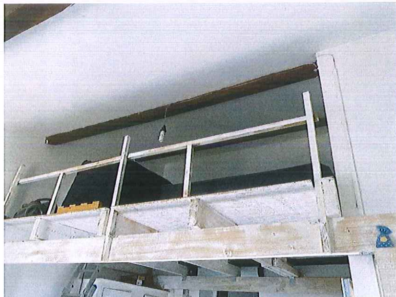
Mezzanine, plancher en bois
